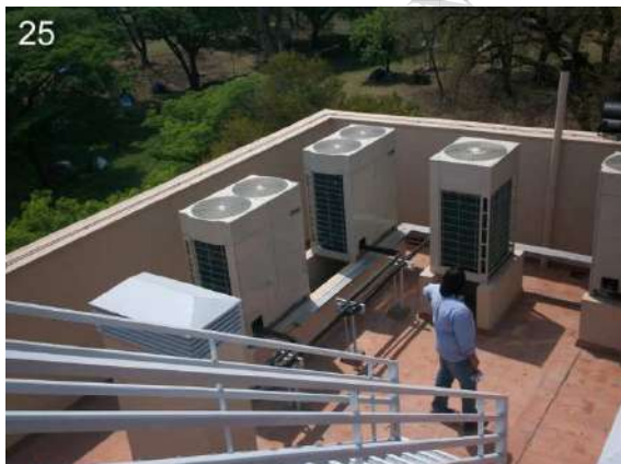
25: Vista de las torres de enfriamiento de los equipos de aire acondicionado.
