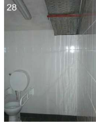
28: Se observa que el espacio para ubicar la silla de ruedas se encuentra planteado para discapacitados zurdos.
