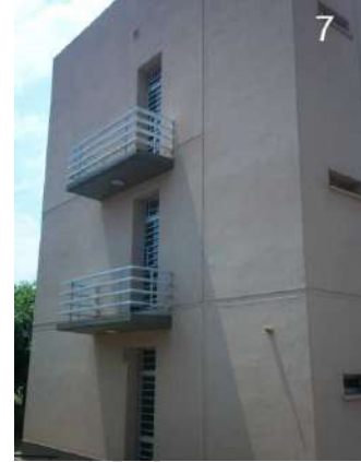
7: Vista del remate lateral del edificio.
