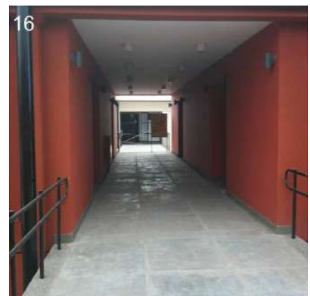
16: Vista del pasillo de acceso a las aulas del primer piso.
