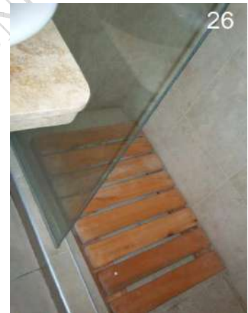
26: Detalle de la ducha de uno de los dormitorios.
