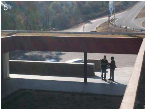
5: Vista del ingreso a la CASA 8.
