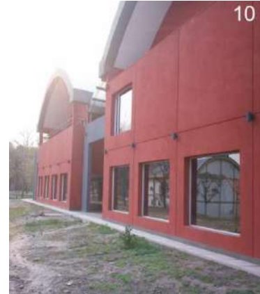
10: Vista general de esta fachada. Las amplias ventanas responden a la galería de circulación.
