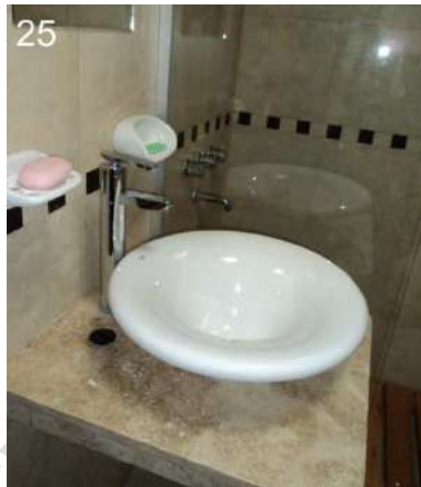
25: Modificación en el lavatorio por bacha y grifería monocomando.
