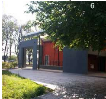
6: Vista de la nave del frente y zona seca de acceso.
