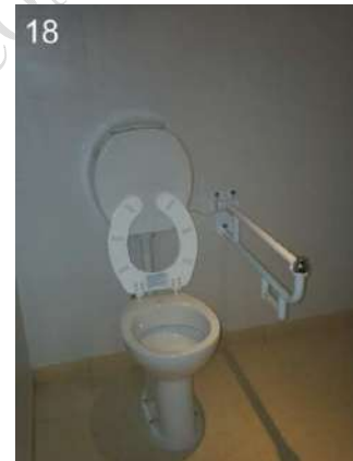
18: Sanitario para discapacitados solo con barral izquierdo.
