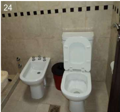
24: Refacción integral del baño.
