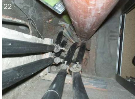
22: Detalle de los plenos verticales del edificio.
