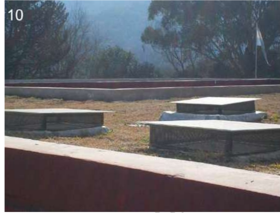
10: Detalle de respiraderos del local inferior.
