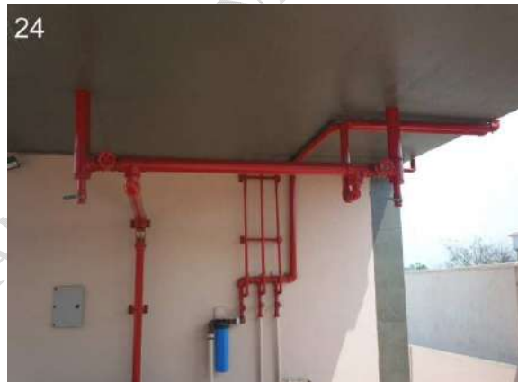
24: Vista de las bajadas desde el tanque de agua. El artefacto azul es un filtro con destino exclusivo para abastecer a los boxes odontológicos.
