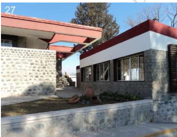
27: Vista de la casilla de Vigilancia. Una construcción nueva, respetando el estilo original de las construcciones preexistentes.
