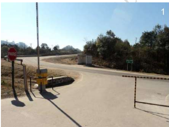
1: Vista desde el camino de acceso hacia la playa de estacionamiento de las Residencias Universitarias.
