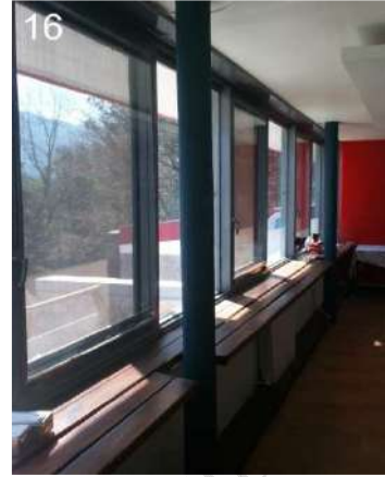
16: Detalle de las carpinterías y estructura del edificio.
